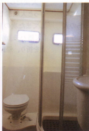
左:メインサロン前部に配置されたシステムキッチン 右:ゲスト用のシャワールーム。ちなみにゲストルームは1室で、広めのWバースが2段入っている
